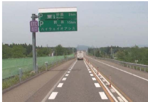
(供用車線の案内標識の移設)
