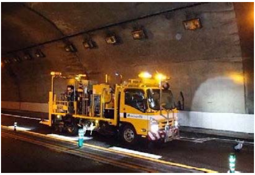
(供用車線の路面標示施工)
