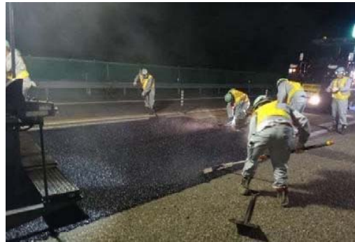
(供用車線の舗装補修)
