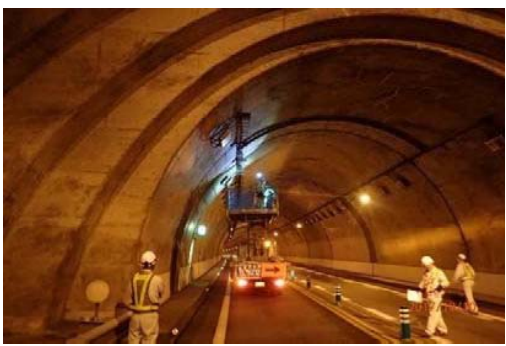
(供用車線のトンネル照明設備更新)
