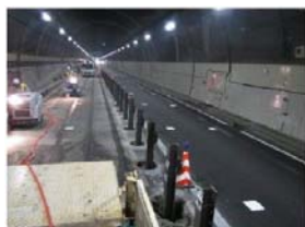
①目隠し板設置工事
