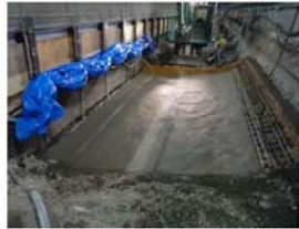
③インバートコンクリート打設(完了)
