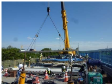
新設コンクリート床版の設置
