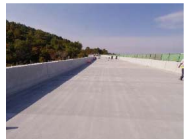
新設コンクリート床版の施工完了
