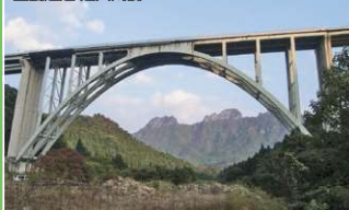
上信越道 込入川橋
