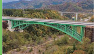
上信越道 太田切川橋
