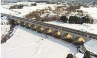
上信越道 あらい高架橋
