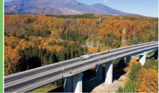
上信越道 れいめい橋
