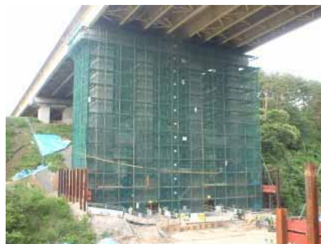
補強工事の実施状況
