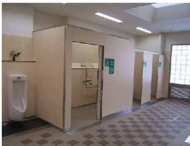
段差解消・多目的お手洗い
