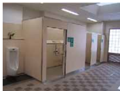
段差を解消したトイレ
