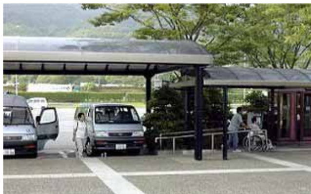
コリドール（屋根付き通路）
