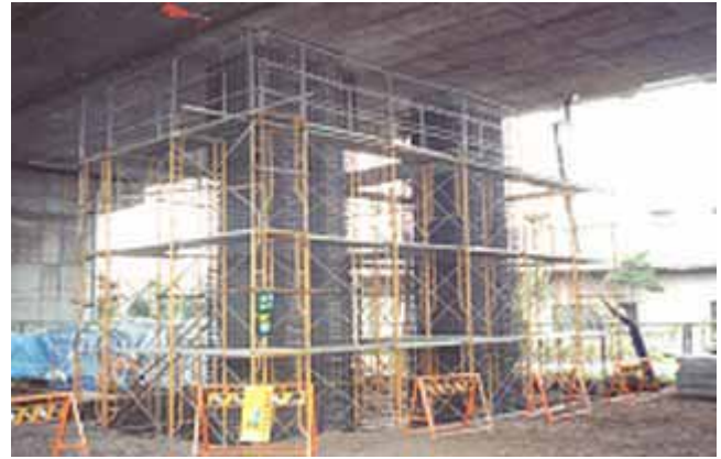
橋脚の耐震補強
