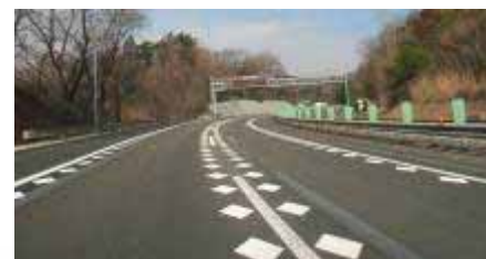
〔完成(下り)313.7KP付近〕
