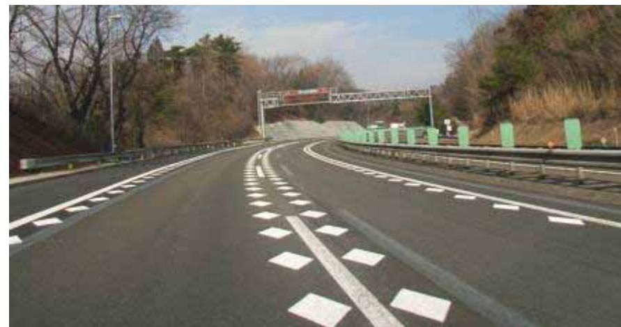
完成【(下り)313.7KP付近】
