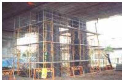
(橋脚の耐震補強)
