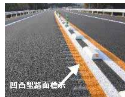
〔暫定2車線区間の車線逸脱防止対策の凹凸型路面表示〕
