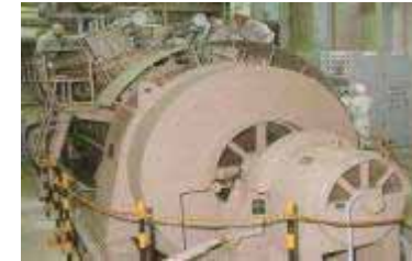
(受配電設備の点検)
