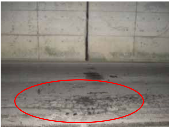
車道上に止水板の破片散乱状況
