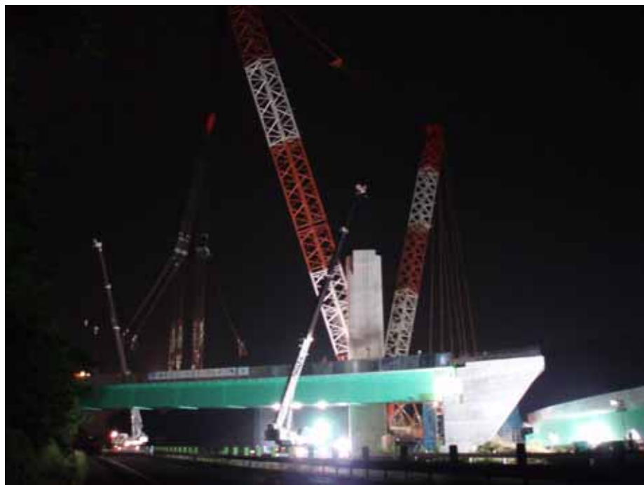
架設工事のイメージ(東北道 富谷JCT架設写真)
