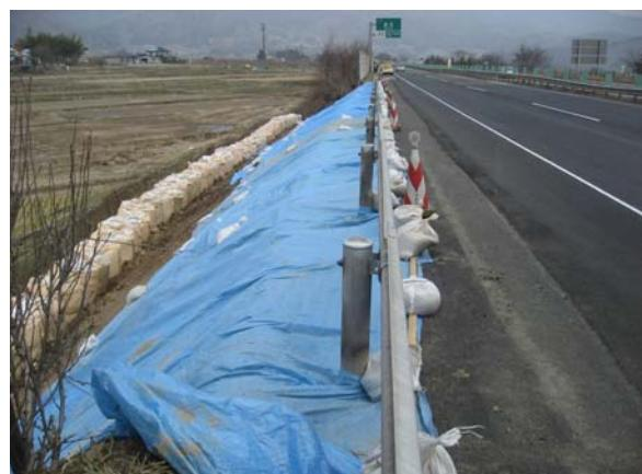
**応急復旧完了** : 道路本体の崩落部を大型土のう（直径 1.2m）で押さえ安定させる
