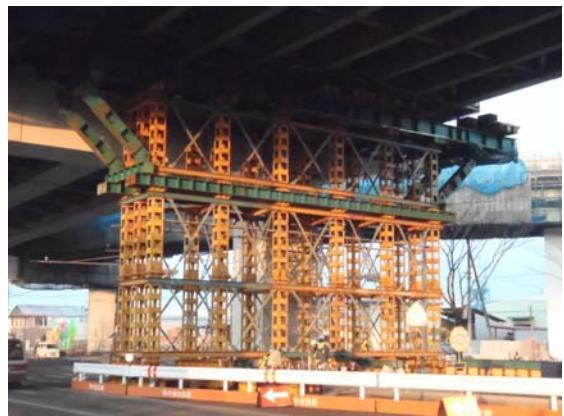
損傷状況：橋脚上に設置した、橋桁を支えている支承が損傷し、鉛直方向、水平方向にずれている。
