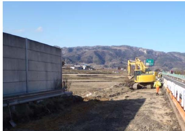
**損傷状況** : 盛土区間における道路本体の崩落と、その進行に伴う路面の亀裂
