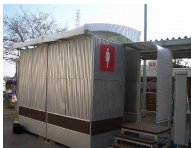
臨時トイレの設置
