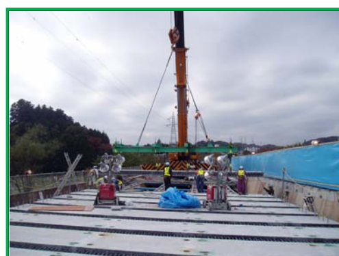
【新設コンクリート床版の設置】
