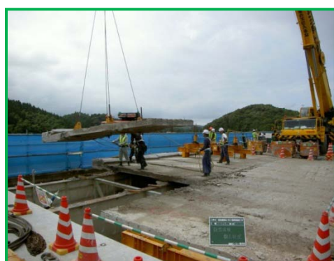
【コンクリート床版の撤去】
