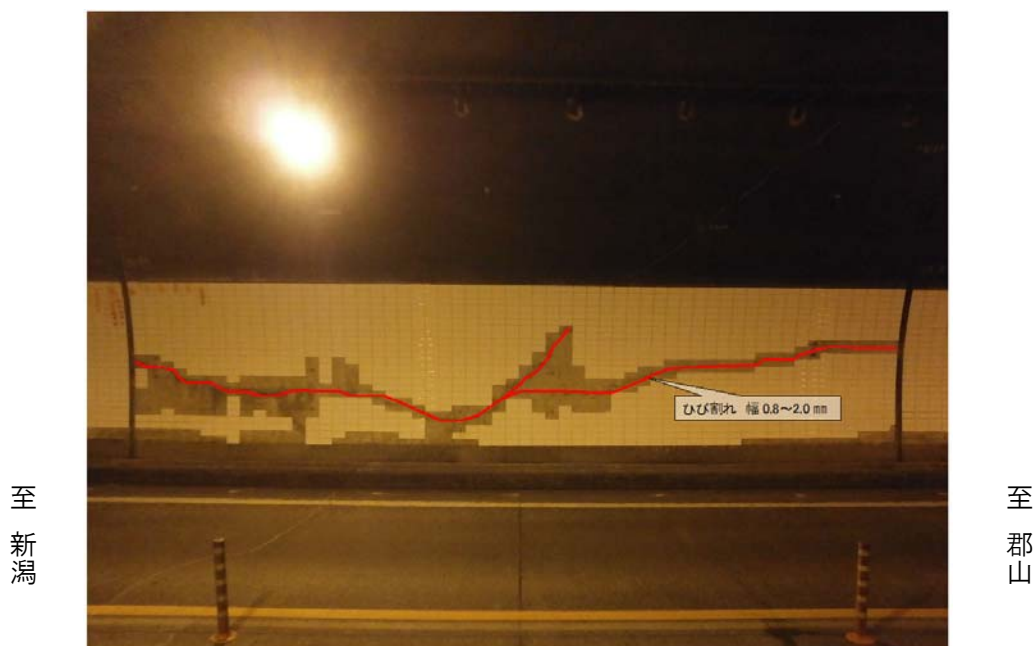
黒森山トンネル状況
