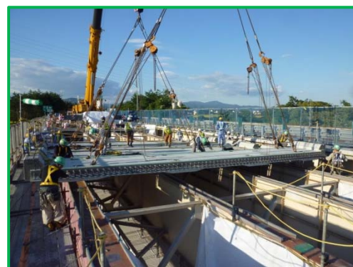
【新設コンクリート床版の設置】
