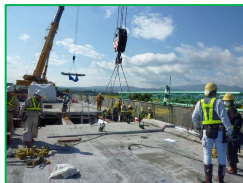
【コンクリート床版の撤去】
