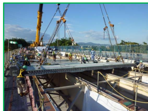
【新設コンクリート床版の設置】
