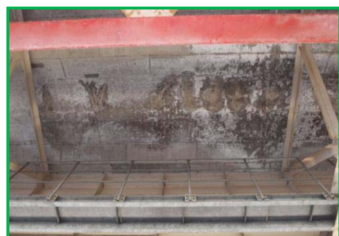
【コンクリート床版裏面ひび割れ状況】
