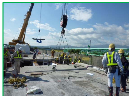
【コンクリート床版の撤去】
