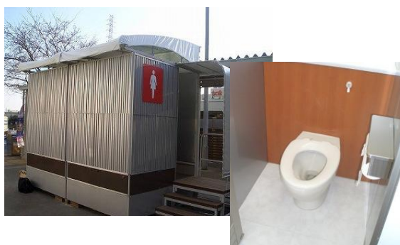
仮設トイレの設置
