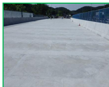
【新設コンクリート床版施工完了】
