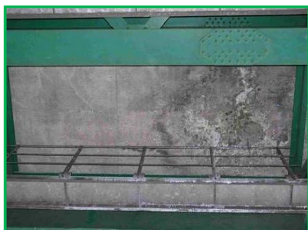
【コンクリート床版裏面ひび割れ状況】
