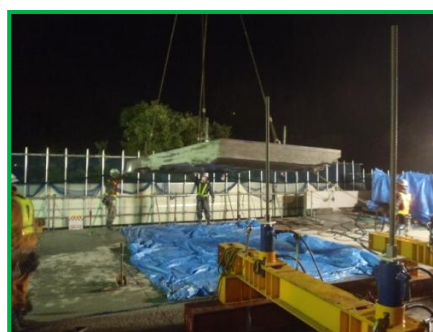
【コンクリート床版の撤去】
