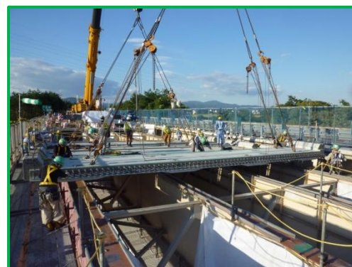
【新設コンクリート床版の設置】
