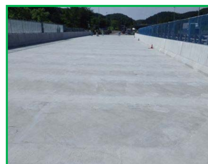
【新設コンクリート床版施工完了】
