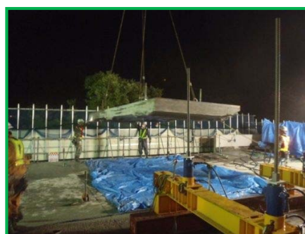
【コンクリート床版の撤去】
