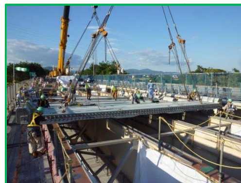
【新設コンクリート床版の設置】
