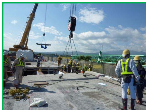
【コンクリート床版の撤去】
