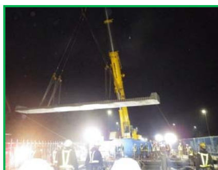
【新設コンクリート床版の設置】
