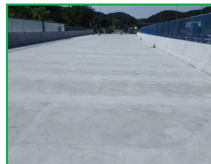
【新設コンクリート床版施工完了】
