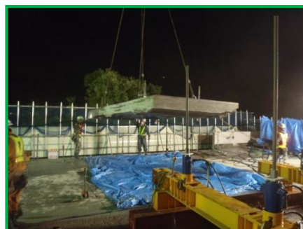
【コンクリート床版の撤去】
