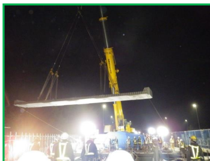
【新設コンクリート床版の設置】
