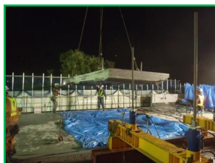
【コンクリート床版の撤去】
