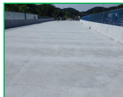
【新設コンクリート床版施工完了】
