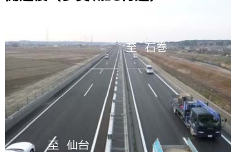
開通後（多賀城IC付近）
