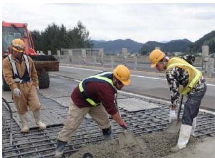
○コンクリート補修
