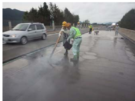
○舗装下面の防水工
