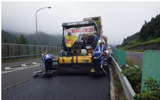
舗装補修工事
