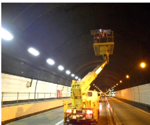
トンネル内構造物の点検・補修
