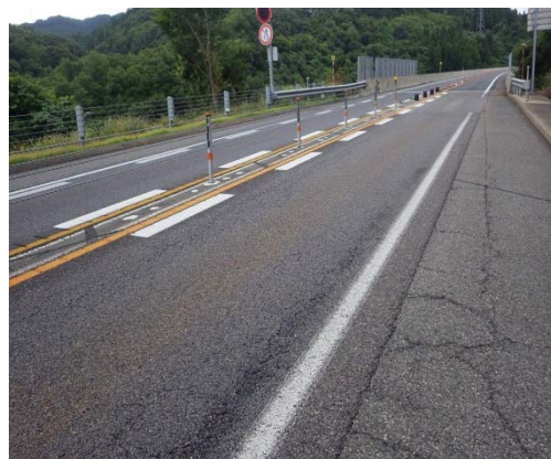
舗装路面の補修(西会津IC～津川IC間)
