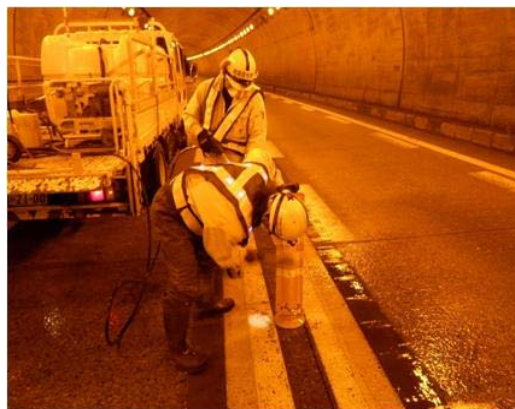
車線分離標の清掃
