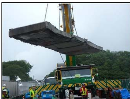
【コンクリート床版の撤去】
