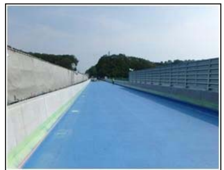
【床版防水施工完了】
