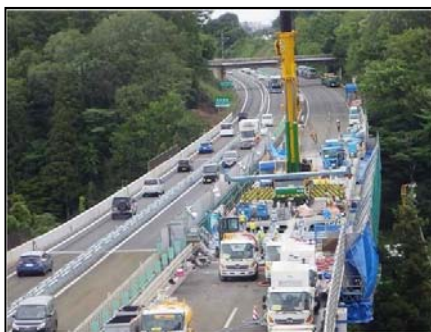
【新設床版の設置】
