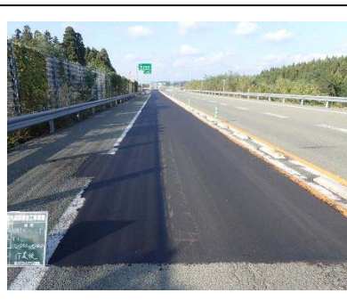
舗装補修状況
