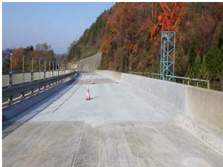
【コンクリート床版補修完了】
