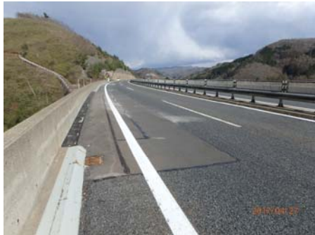
【コンクリート床版補修完了】
