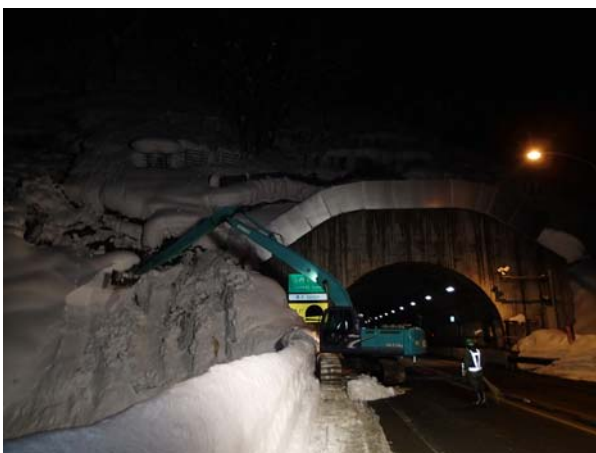
＜H26のトンネル坑口部除雪状況＞
