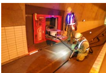
トンネル設備点検②
