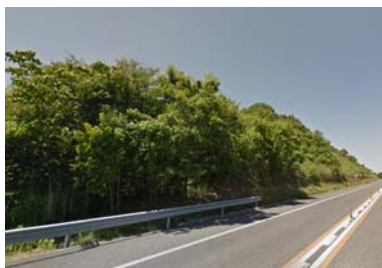
4車線化工事 （仮設落石防止柵設置前）
