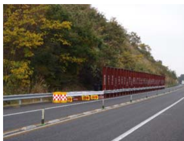
4車線化工事 （仮設落石防止柵設置後イメージ）
