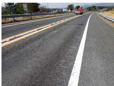
舗装補修工事（施工前）
