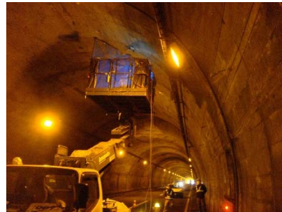
トンネル補強工事
