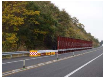
4車線化工事 （仮設落石防止柵設置後イメージ）
