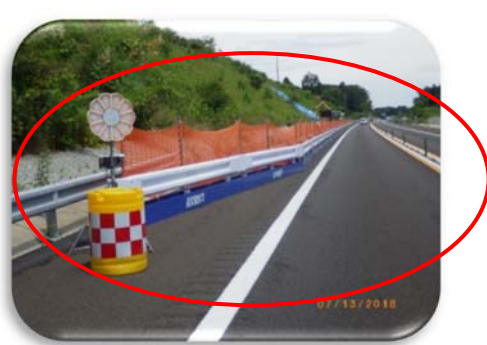
撤去資材状況
