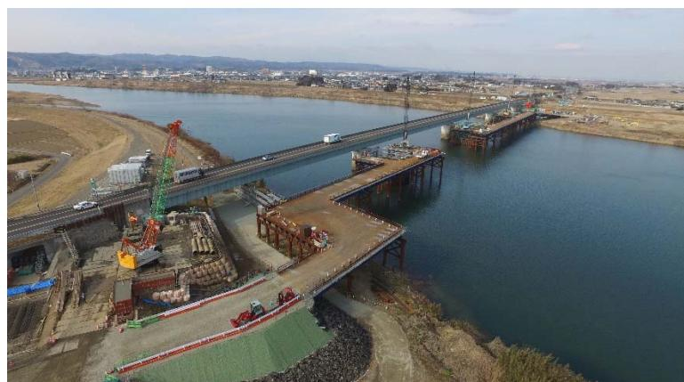
常磐自動車道4車線化工事区間内の、阿武隈大橋の工事現場をご案内いたします。ニューマチックケーソン工法という特殊な工法を用いて建設しています。
