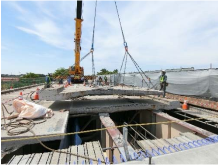
【古い床版撤去状況】
