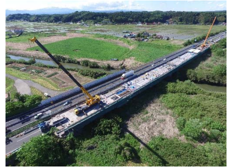
【対面通行規制状況】
