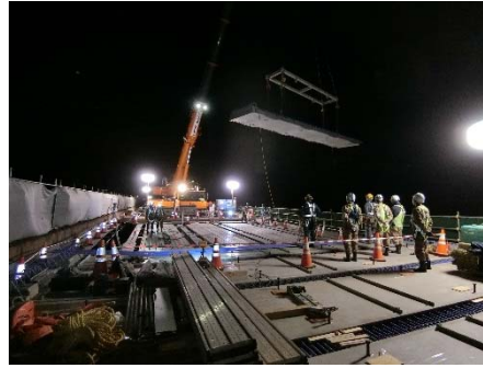
【新しい床版設置状況】
