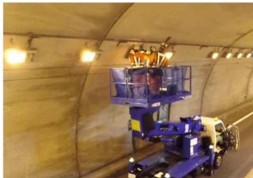
【トンネル照明設備更新状況】
