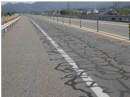
【路面損傷状況】
