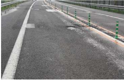
【路面損傷状況】
