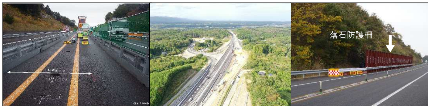
①中央分離帯の防護柵設置
