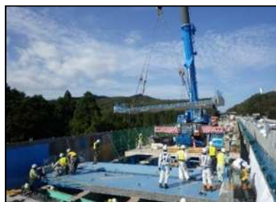
【新しい床版設置状況】
