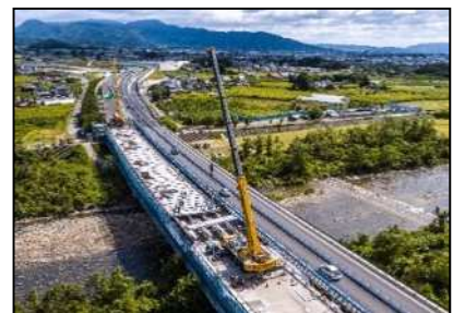
【対面通行規制状況】
