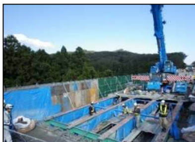
【古い床版撤去状況】
