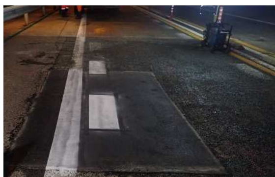
【路面補修後状況(イメージ)】
