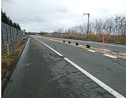
舗装損傷状況
