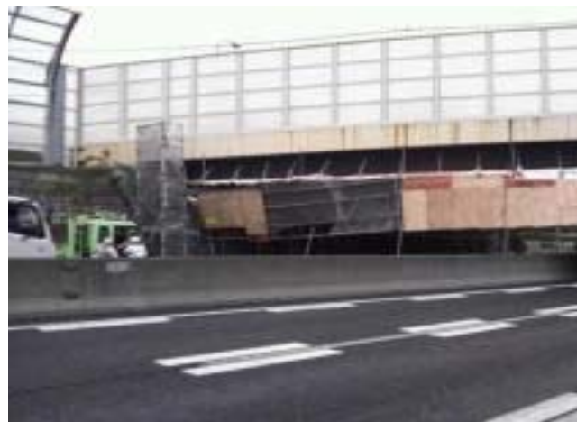
・上り線から下り線を見た状況(東京方面から撮影)
