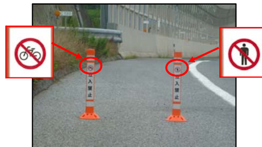
(高速道路出入口部の路肩にポール設置)
