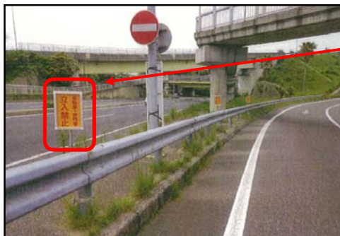
(高速道路出入口部に進入禁止看板)
