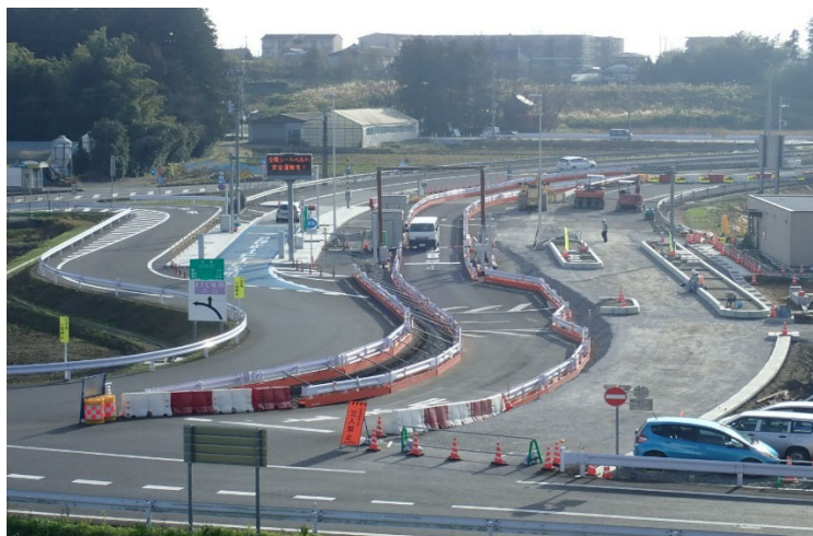
料金所嵩上げ工事中(写真中央、赤白色ガードレールが仮設通路) 11月28日撮影
