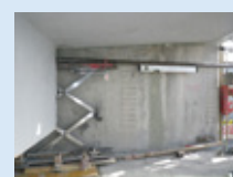
コンクリートはつり工 (はつり装置と移動システム)
