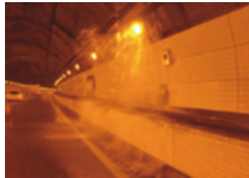
防災本管の漏水発生状況
