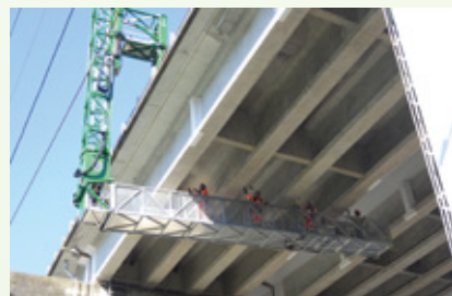
大型橋梁点検車による点検実施例
