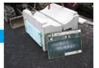
4. 凹部に EPS 取付け (中央分離帯側のみ)
