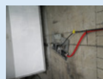
鉄筋防錆材吹付 (吹付ノズルと移動システム)
