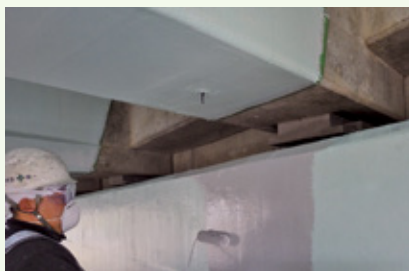
コンクリート片はく落防止対策の施工例②
