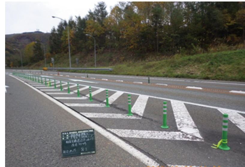
逆走防止対策のため設置された簡易着脱型ラバーポールの全景
