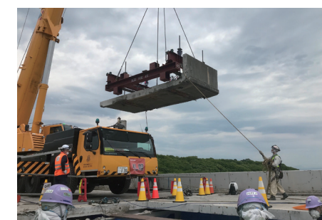
古い床版撤去状況
