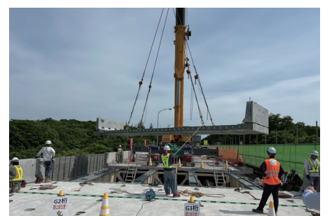
新しい床版設置状況
