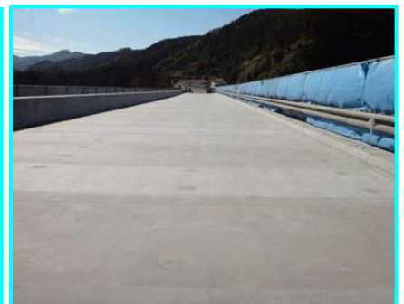
【新設コンクリート床版施工完了】
