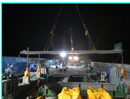
【新設コンクリート床版の設置】
