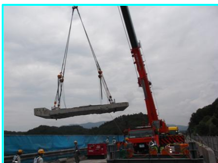
【コンクリート床版の撤去】
