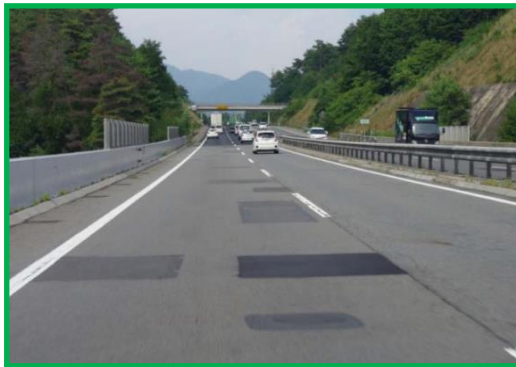
【舗装路面の損傷状況(小仁熊橋)】
