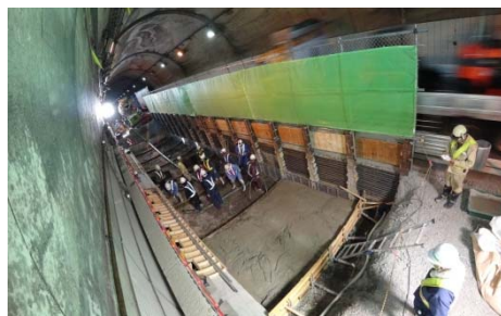
② 掘削～型枠～コンクリート打設
