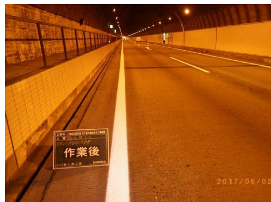
路面標示補修工事
