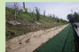
のり面への植樹
