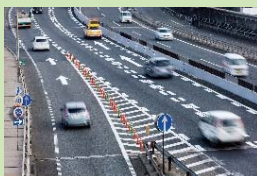
高速道路本線への合流部の逆走対策
